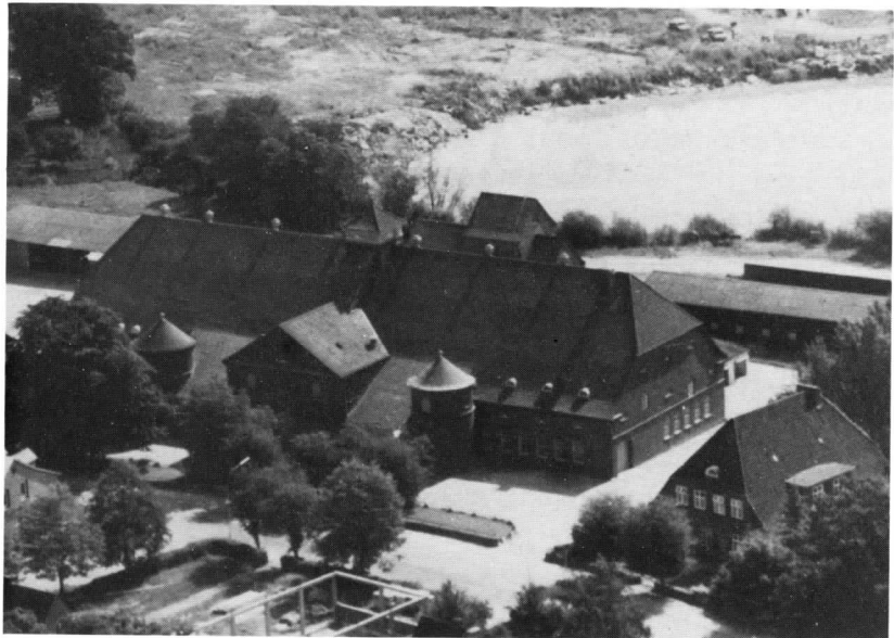
Abb. 190 1974, AIsenhof, Straßenansicht. Im Hintergrund Rest der "Alten Kreidegrube AIsen".
